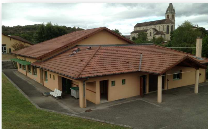
Vue arrière du bâtiment
