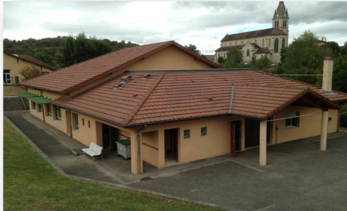
Vue arrière du bâtiment
