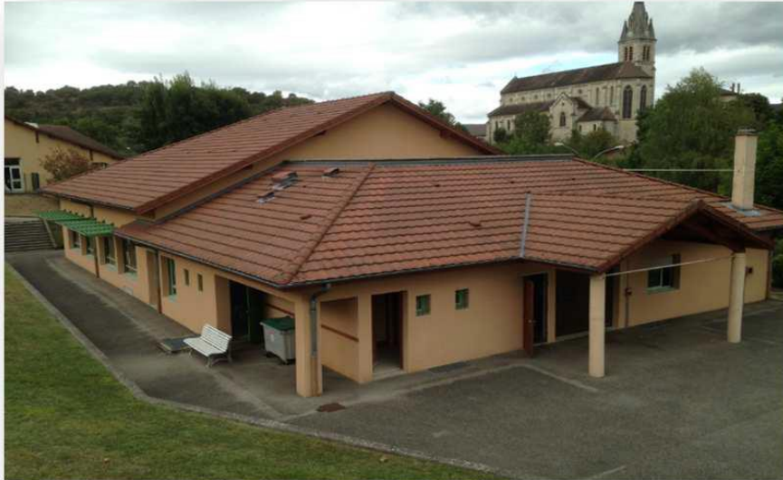
Vue arrière du bâtiment
